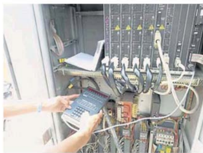
失灵的交通灯感应器已抢修。
