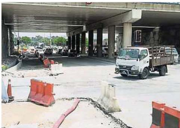
承包商在高架天橋底下增設車道工程，最遲6月前完成。
