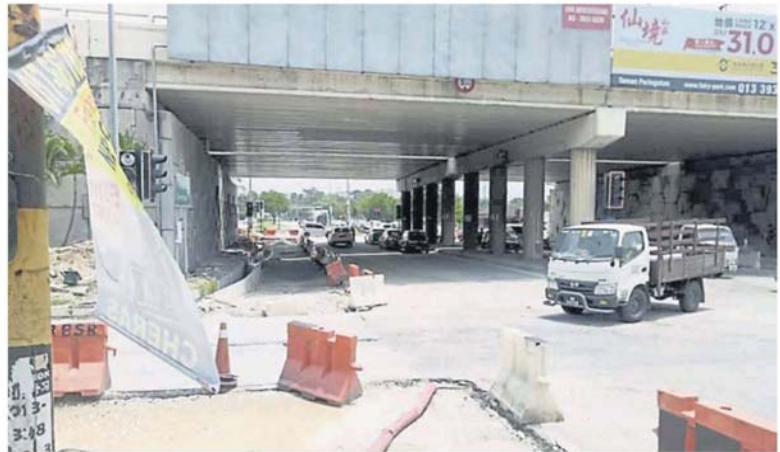
皇冠城主要道路路口的马路加宽工程已进行了一半。
